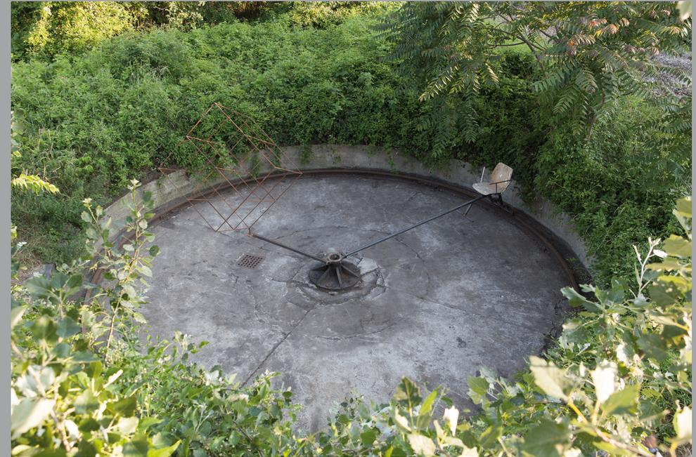
Eine runde, in den Boden eingelassene Betonwanne ist der Überrest einer Drehscheibe des alten Bahnhofs, 7m im Durchmesser, eine Grube von 1m Tiefe. Die Installation ist in der Mitte auf einer Metallkonstruktion befestigt, durch Kugellager lässt sich diese im Kreis drehen. An einem Ende ist ein Stuhl montiert, der sich wiederum über zwei Räder aus den abgestellten Zügen entlang des äußeren Radius' bewegt. Am anderen Ende befindet sich ein Würfel aus einem Drahtgestell.
